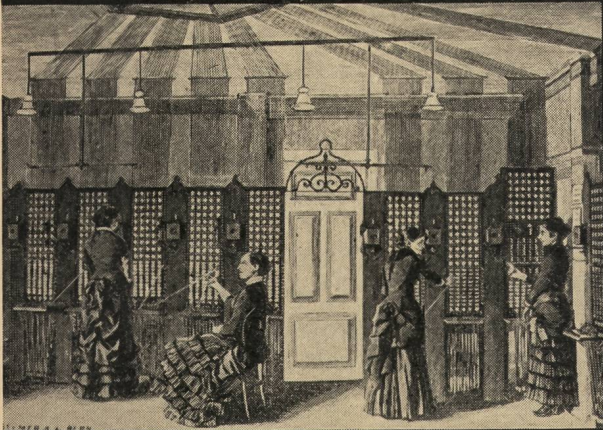
Erste handbediente Telephonzentrale
