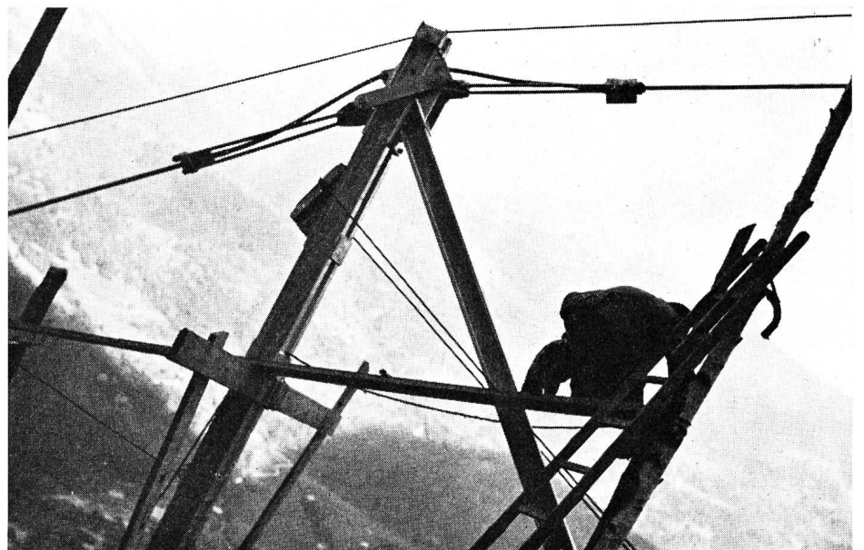
Fig. 8. Abspannklemmen an einem Zwischenmast eingesetzt. Das Kabel zwischen den Abspannklemmen ist zuglos Brides d'attache montées sur un mât intermédiaire. Le câble n'est soumis à aucun effort de traction entre les brides
