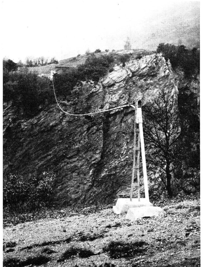
Fig. 19. Tobelüberführung; Spannweite 190 m Traversée d'un ravin; portée 190 m
