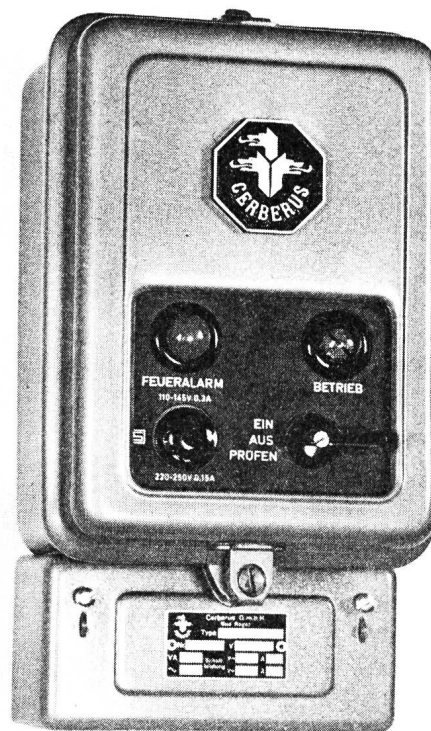
Fig. 12. Kleinzentrale für Cerberus-Feuermelder
