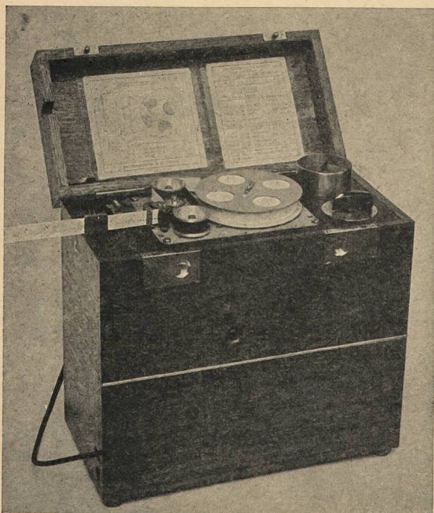
Apparat zur Kontrolle der Gesprächstaxierung
