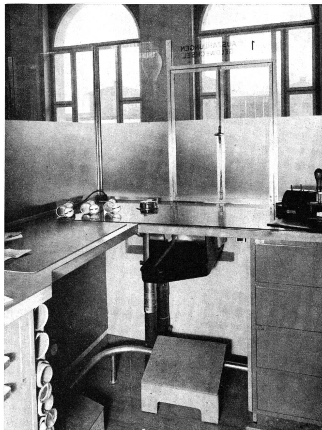
Fig. 16. Schalter im Geldamt Aarau mit horizontalem Hausrohrpost-Empfänger unter der Schalterplatte Guichet de l'office des mandats d'Aarau avec récepteur pneumatique horizontal placé sous la tablette de guichet
