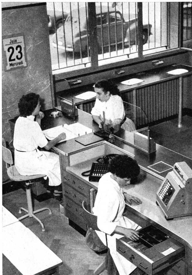
Fig. 15. Schalteranlage im Telephon- und Telegraphenbüro des PTT-Gebäudes Lausanne-St-François. Am linken Ende des Schalters ist der Sender und die Empfangsmulde der Hausrohrpost ersichtlich
