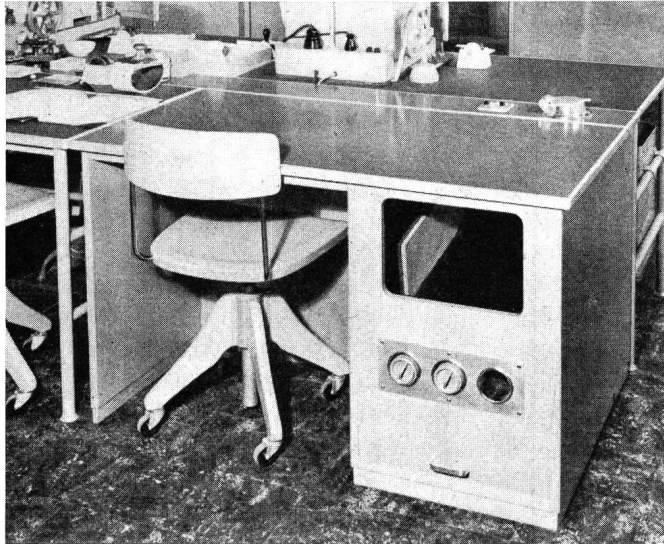
Fig. 23. Sende- und Empfangsstelle der Stadtröhrepost mit horizontaler Büchsen-Ausschleusvorrichtung im Telefon- und Telegraphenbüro in Olten
