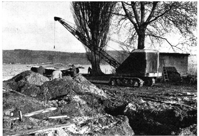
Fig. 1. Die Kabel-Baustelle in Meyriez
