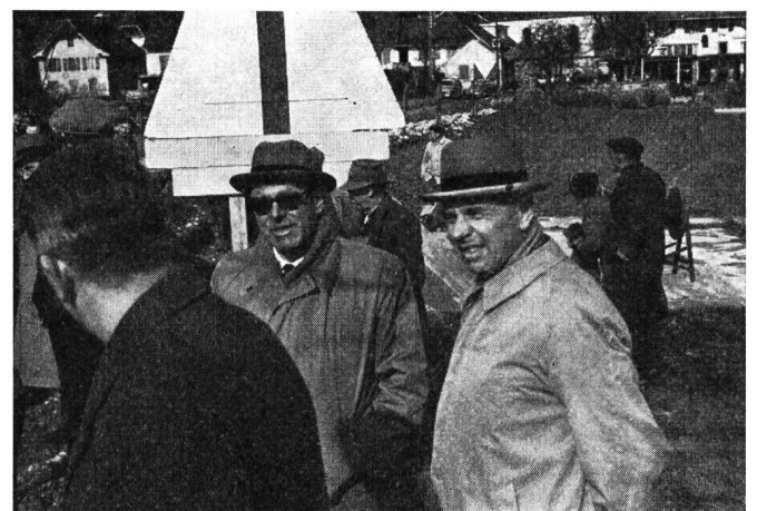
Fig. 6. Direktor G. A. Wettstein (rechts) und Inspektor F. Weber vom Liniendienst der TT-Abteilung verfolgen die Arbeiten sichtlich zufrieden. Im Hintergrund das grosse Visier, das für den Auszug des Stahlseiles von Meyriez nach Môtier diente
