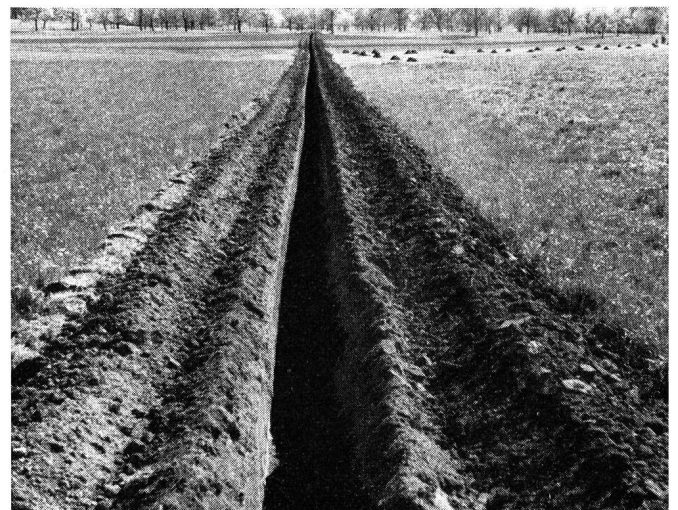
Fig. 10. Beispiel eines mit Kettenbagger ausgehobenen Grabens. Das Material ist getrennt gelagert Exemple d'une fouille creusée au moyen d'un excavateur à chaîne sans fin à godets. Le matériel est déposé séparément de chaque côté de la fouille
