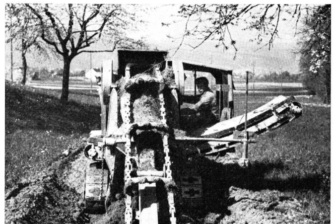
Fig. 4. Kettenbagger (Vorderansicht) Excavateur à chaîne sans fin à godets (vue frontale)
