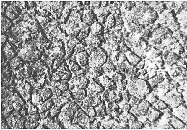
Fig. 31. Gleiche Probe wie bei Figur 30; Salzkruste mit 2n Essigsäure entfernt. Interkristalline Korrosion auf der Oberfläche der eingetauchten Hälfte des Bleiblechs. Vergrößerung: 37 ×
