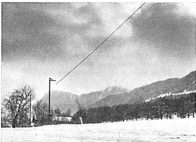
Fig. 6. Praktisch ausgeführte G-Leitungsstrecke als Fernzubringer, mit senkrechter Aufhängevorrichtung mittels Nylonschnur an Holzmasten (Photo Kathrein, Rosenheim)
