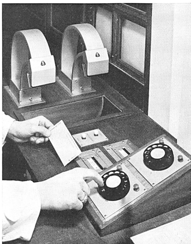
Fig. 11. Zettel-Rohrpost in der Bibliothek der ETH in Zürich. Anordnung der Druckluftsender mit den zugehörigen Wählscheiben sowie den Saugluftempfängern
