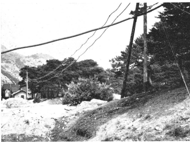
fig. 2. De même que la circulation, les liaisons téléphoniques furent interrompues plusieurs heures entre Sion et Brigue, ainsi qu'entre La Souste et Tourtemagne. Le personnel de la direction des téléphones de Sion envoyé sur place rétablit les communications au moyen de câbles aériens traversant le lit encore mouvant du torrent
