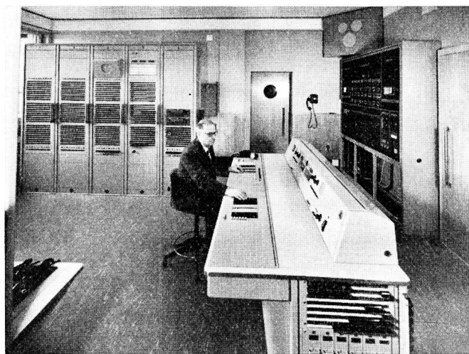
Fig. 7. Einer der beiden zentralen Schalt- und Kontrollräume Uno dei due centri di commutazione e di controllo
