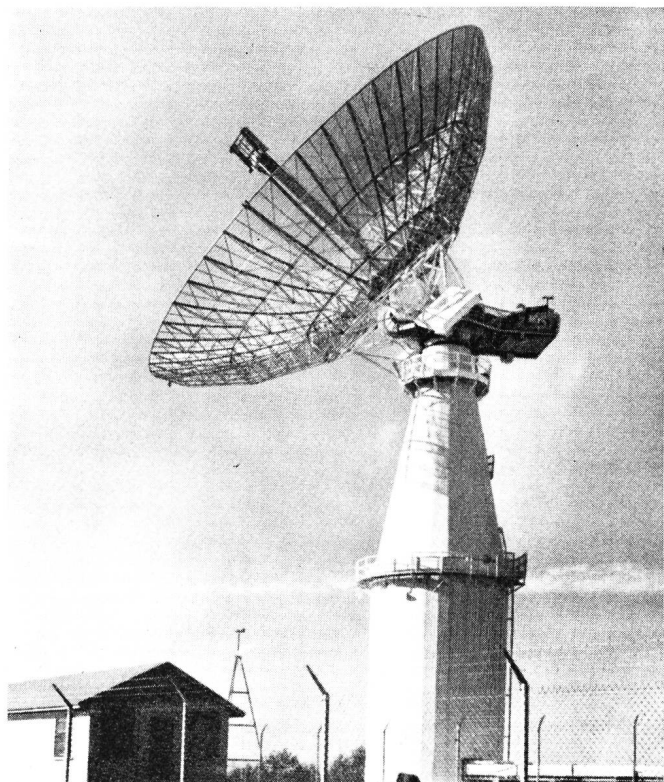
Fig. 10. Antenne parabolique servant aux liaisons avec les satellites, diamètre environ 26 m (Tiré du Rapport technique n° 32-137 de la NASA)
