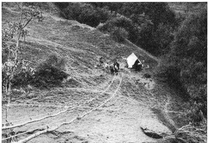
Fig. 3. Câbles provisoires, installation terminée
