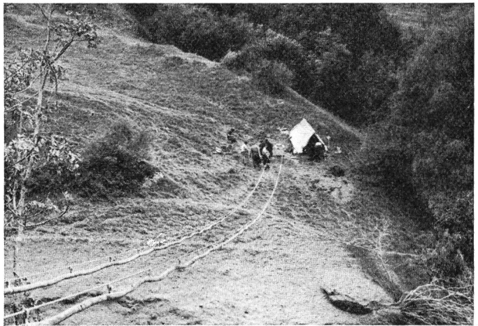
Fig. 3. Câbles provisoires, installation terminée
