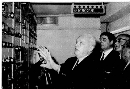
Fig. 3 Equipements techniques du central d'Andorre-la-Vieille
