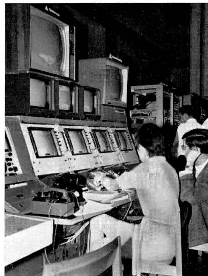
Unser Bild zeigt das an der FERA aufgestellte Farb-Bildregiepult, im Hintergrund der Filmabtaster. Für farbige Ansagen stand ausserdem eine Plumbikonkamera zur Verfügung (siehe Titelbild dieser Nummer).
