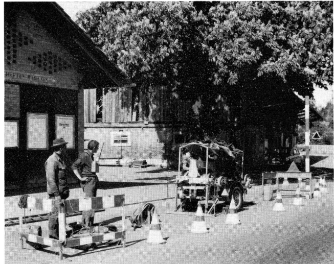
Fig. 22 Einzugwinde mit Benzinmotorantrieb
