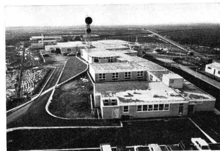
Fig. 3 Dieser im Zusammenhang mit der zweiten Antennenanlage erweiterte Bau beherbergt die zentralen Einrichtungen der Bodenstation von Goonhilly Downs, so unter anderem die zentrale Überwachung, die Büros und die Wohlräume. Im Hintergrund die Endstelle der Richtstrahlstrecke nach Plymouth-Bristol-London
