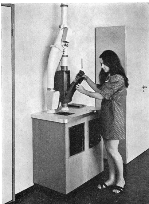
Fig. 9 Ansicht einer Rohrpoststation in einem Büro
