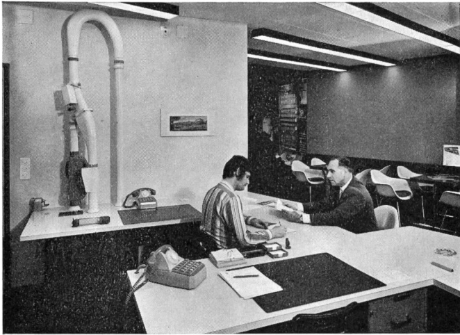
Fig. 8 Rohrpoststation mit Überfahrbogen in der Schalterhalle
