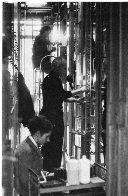
Fig. 15 Reinigungsarbeiten an Wählerrüstungen Nettoyage d'équipements de sélecteurs
