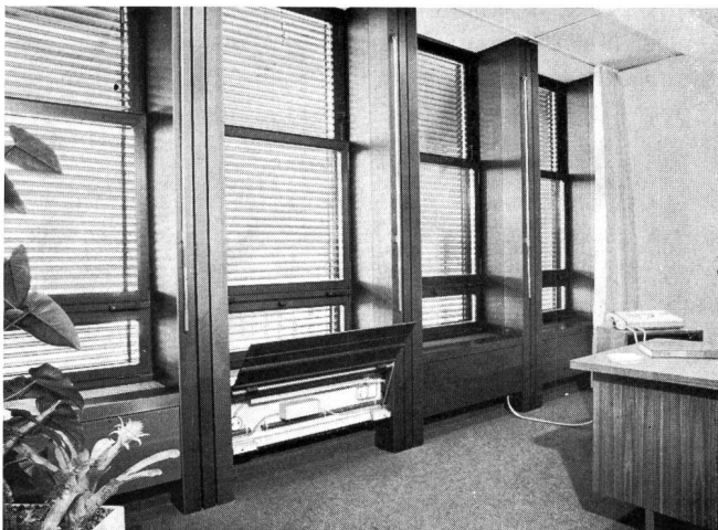
Fig. 10 In neuem Verwaltungsbau in die Fensterkonstruktion eingebauter Brüstungskanal Canal d'allège monté dans la construction des fenêtres d'un nouveau bâtiment administratif
