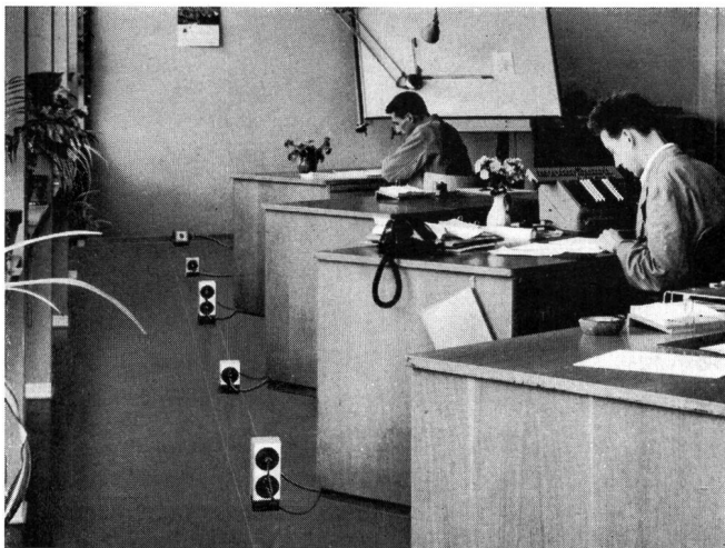
Fig. 12 Montierte Anschlussaufsätze auf Bodenkanal, Überflursystem Supports de raccordement montés sur un système de canaux à niveau du sol
