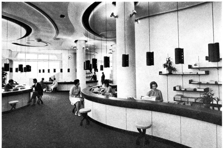
Fig. 1 Gesamtansicht des neuen Informationszentrums des Kundendienstes in Zürich
