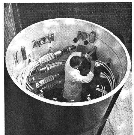
Fig. 2 Dieser Zwischenverstärkerschacht ist für die Feldversuche mit dem neuen 60-MHz-Koaxialkabelsystem von der Britischen PTT entwickelt worden. Man hofft das neue Kabel 1973 zwischen London und Birmingham in Betrieb nehmen zu können (Photos: COI/BPO)
