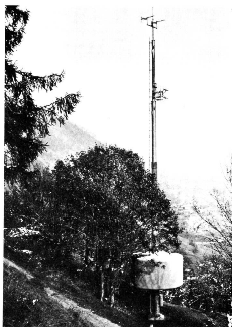
Fig. 2 Cabine de station émettrice montée sur mât pour OUC et TV (Ferden dans le Lötschental) – Cabina per pilone d'antenna per stazioni a OUC e televisive (Ferden nel Lötschental)
