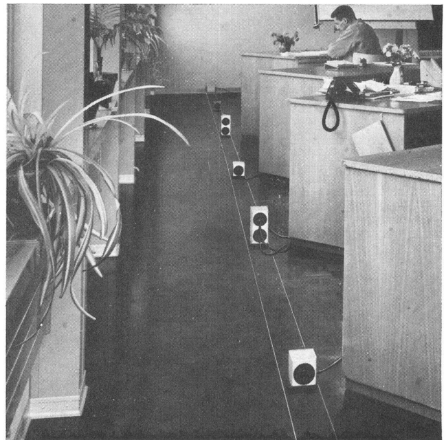
Fig. 7 Überflur-Bodenkanal (abdeckbar), mit montierten Anschlussauf-sätzen – Canal au ras du sol (avec couvercle) et potelets de rac-cordement
