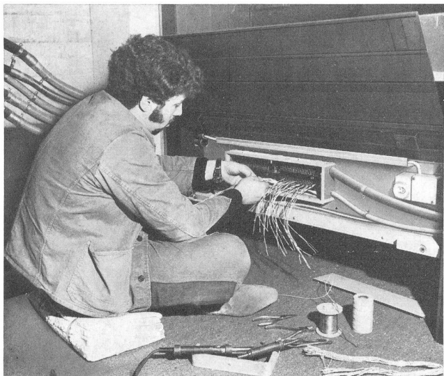
Fig. 3 Telefonmonteur beim Anschliessen eines Brüstungs-Zwischenverteilers – Monteur des téléphones raccordant un répartiteur intermédiaire d'allège
