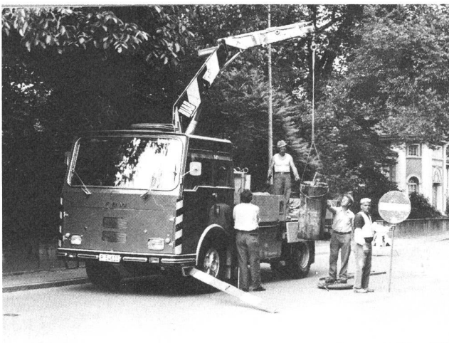
Fig. 8 Verlad der alten Pupintöpfe – Prise en charge des anciens caissons Pupin
