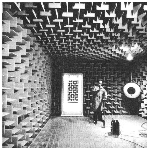
Fig. 6 Chambre anéchoïque de la Division des Recherches et du Développement de l'Entreprise des PTT suisses
