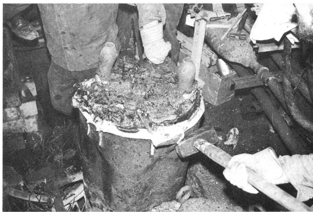
Fig. 6 Demolizione dei residui con la mazza
