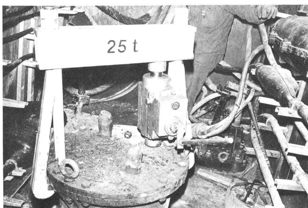
Fig. 4 Dispositivo di demolizione pronto per l'uso
