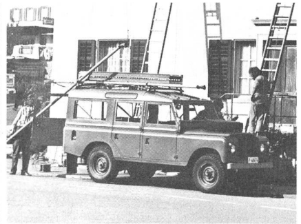
Telefonleitungs- oder Freileitungsbau
