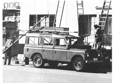
Telefonleitungsmontage oder Freileitungsbau
