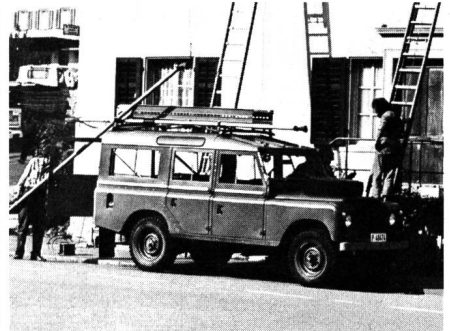
Telefonleitungs montage oder Freileitungsbau
