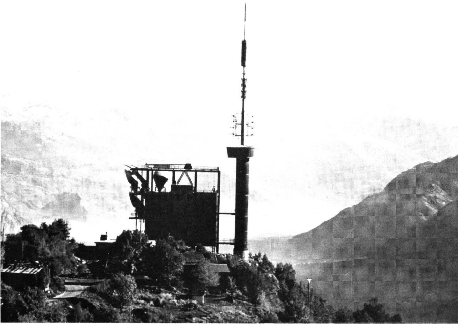
Mehrzweckanlage Ravoire (Wallis) für UKW-Rundspruch, Fernsehen, TV- und Telefonie-Richtfunkverbindungen
