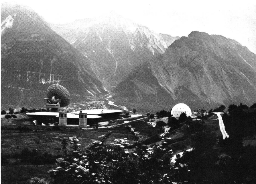
Satelliten-Bodenstation Leuk (Wallis) Station terrestre pour liaisons par satellite de Loèche (Valais) Satellite earth station at Leuk (Valais)
