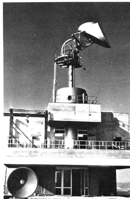
Antennenmessplatz auf dem Dach des Hochhauses der Abteilung Forschung und Entwicklung
