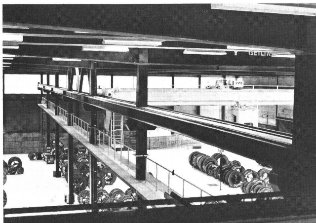
Fig. 5 Laufbahn und Begehungssteg einer Krananlage
