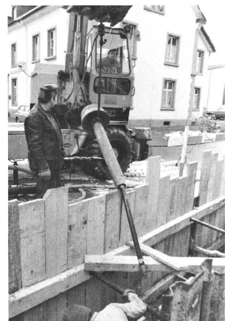
Fig. 5 Einführen des Rammapparates in die Arbeitsgrube. Der Konus an der Spitze des Apparates dient dem Ausweiten der Stahlrohre und gewährleistet die einwandfreie Kraftübertragung und Rammgenauigkeit
