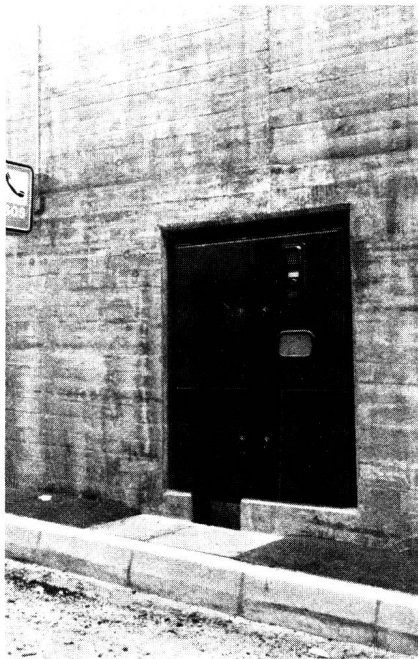
Fig. 1 SOS-Kasten mit Gegensprechanlage und Handfeuerlöschern — Poste SOS avec installation d'interphone et extincteurs à main
