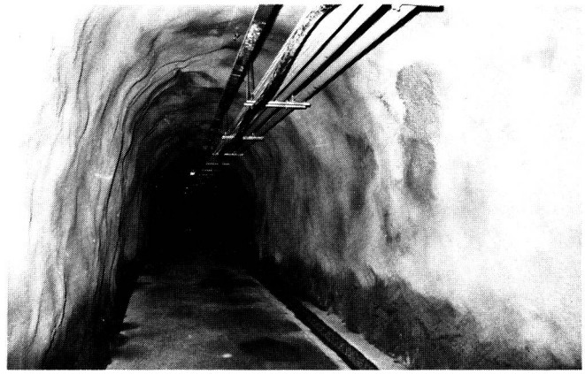
Fig. 7 Blick in den für die Fahrer normalerweise unzugänglichen Sicherheitsstollen — Aperçu de la galerie de sécurité habituellement inaccessible aux conducteurs
