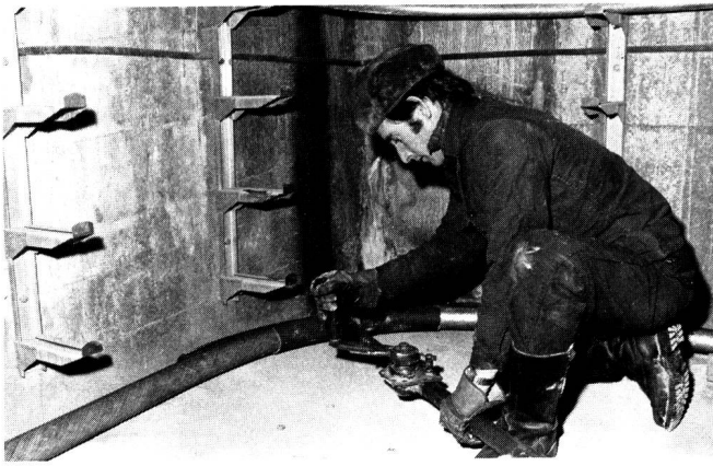
Fig. 13 Zum Abbiegen des Kabels in kurze Bogen mussten, damit das Kabel nicht beschädigt wurde, dem Kabeldurchmesser genau angepasste Rohrhalschalen und entsprechende Rätchenwerkzeuge verwendet werden — Per la curvatura del cavo in piccoli raggi, senza danneggiarlo, si dovette far uso di speciali attrezzature e forme perfettamente adattate al diametro del cavo stesso
