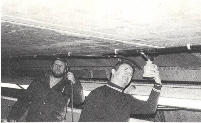
Fig. 8 Schumpfen des Schutzschlauches auf den HF-Steckverbindungen — Rétraction du tube protecteur placé sur les connexions HF à fiches
