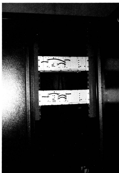
Fig. 5 Anordnung der Breitbandverstärker in einem Tunnelquerschlag — Disposition des amplificateurs à large bande dans une niche latérale du tunnel
