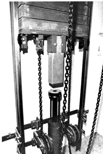
Fig. 3 Gegengewicht eines Personenaufzugs mit Gewichtsausgleichsketten
