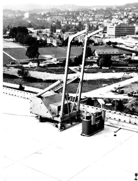
Fig. 10 Arbeitsbühne auf dem Dach abgestellt
