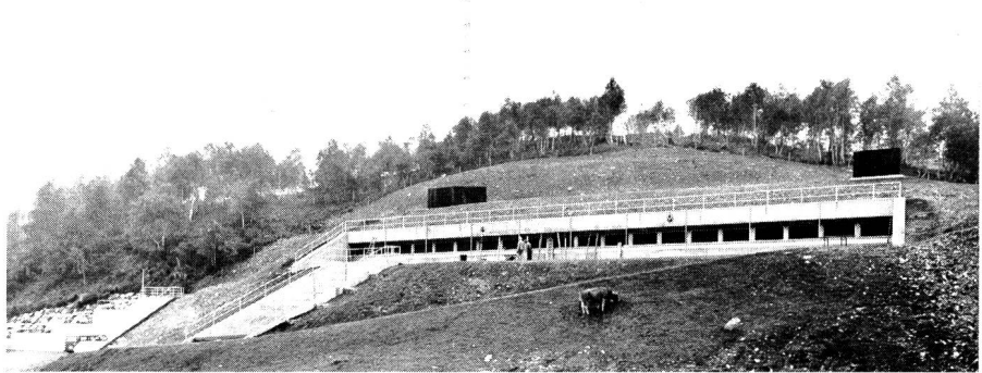
Fig. 1 Ansicht der Sendeanlage mit der in der Galerie untergebrachten Luftfassung zur Kühlung und dem 250 m hohen, mehrfach abgespannten Sendemast
