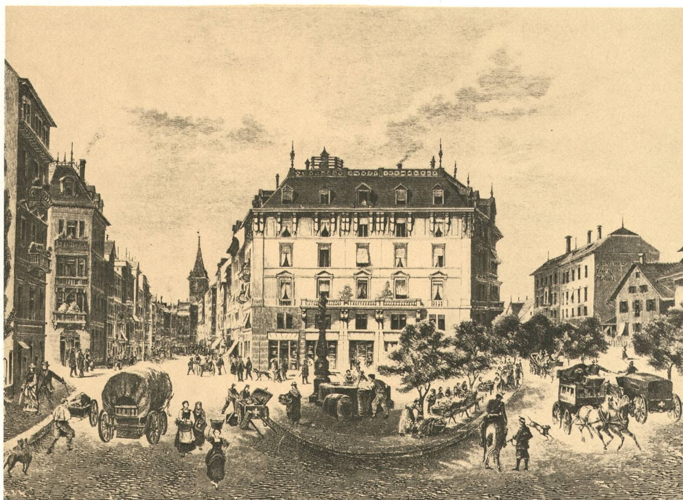
Maison au Rennweg 59, où le premier poste de commutation (central) a été installé dans une mansarde — House No. 59 Rennweg, where the first exchange office was installed in the attic (Photo: Baugeschichtliches Archiv Zürich)
