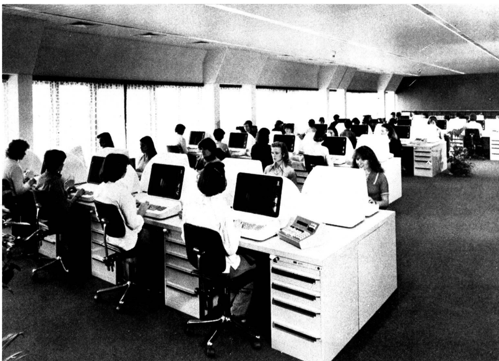
Le système Terco permet aux téléphonistes du service des renseignements d'extraire en quelques secondes d'une banque de données centrale les informations nécessaires, à l'aide d'un terminal approprié — Terco system allows the operator to retrieve within a second information from the central data bank with a corresponding terminal
