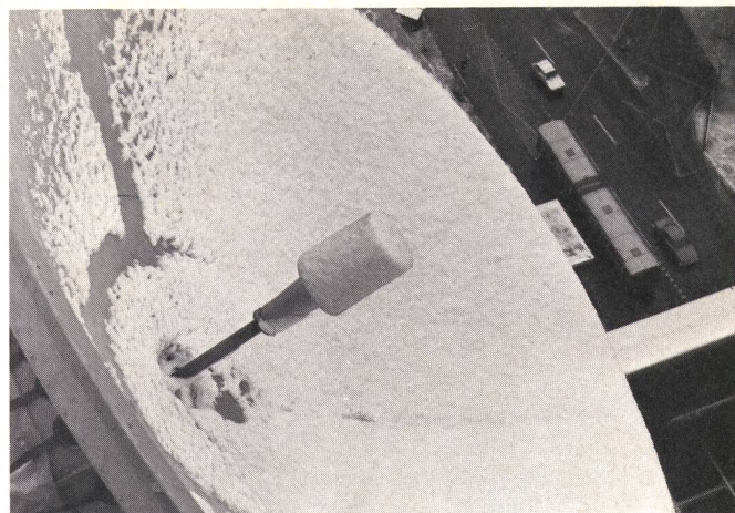
Fig. 9 Schneebedeckte OTS-Empfangsantenne, Ansicht von oben
