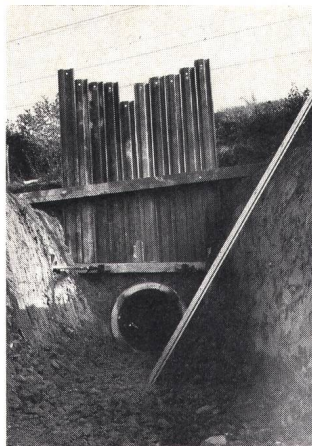
Fig. 2 Der Endschacht ist 3,5 m tief und liegt unmittelbar unterhalb der Bahnböschung
