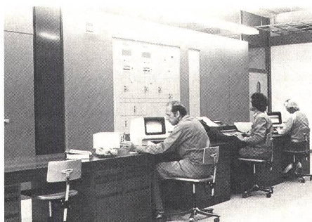
Zentraler Mess- und Prüfraum der Hauptzentrale
