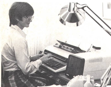
Fig. 5 Modular aufgebautes Textsystem mit Speicher- und Kommunikationsmöglichkeiten (Olympia ES 180)
