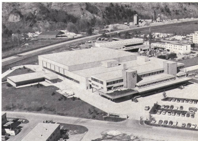
Fig. 1 Ansicht von Süden
