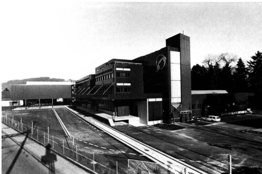
Fig. 1 Das neue Material- und Werkstättegebäude in Gwatt bei Thun von Süden her
