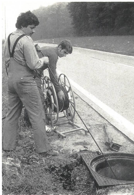
Fig. 9 Ausspülen des Bleirohres mit Hochdruckschlauch
