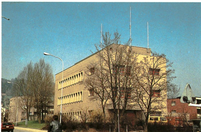
Fig. 8 Antennenanlage auf einem Gebäude für eine Funkzelle mit drei Rundstrahlern (1 Sendeantenne und 2 Empfangsantennen für Diversity-Betrieb)
