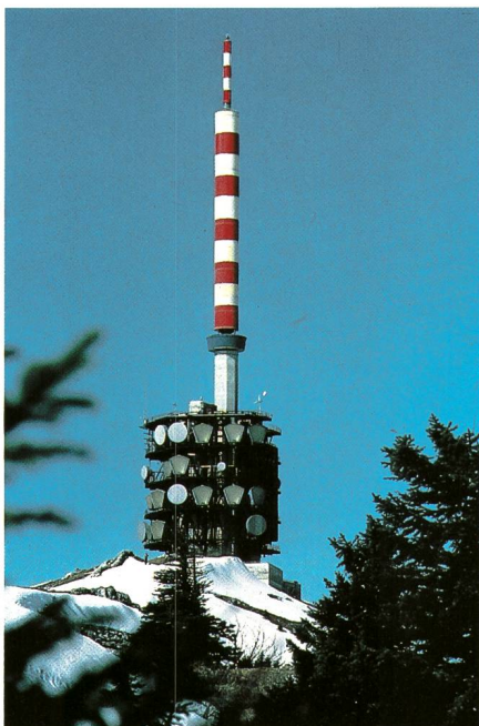
Fig. 4 Mehrzwecksendeanlage für UKW und Fernsehen Impianto di trasmissione a scopi multipli per OUC e TV
