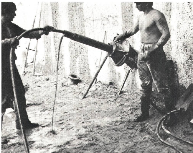
Fig. 6 Die Anker werden montiert
