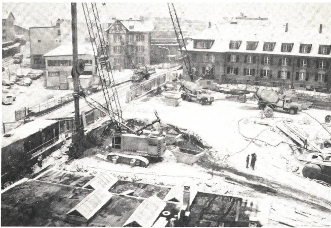
Fig. 5 Beginn der Schlitzwände
